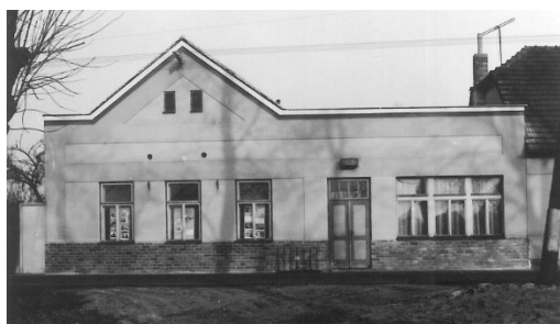
Kino s knihovnou po opravě r.1973
