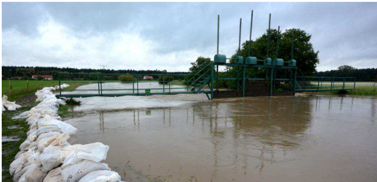
Pytle na hrázi u stavidla
