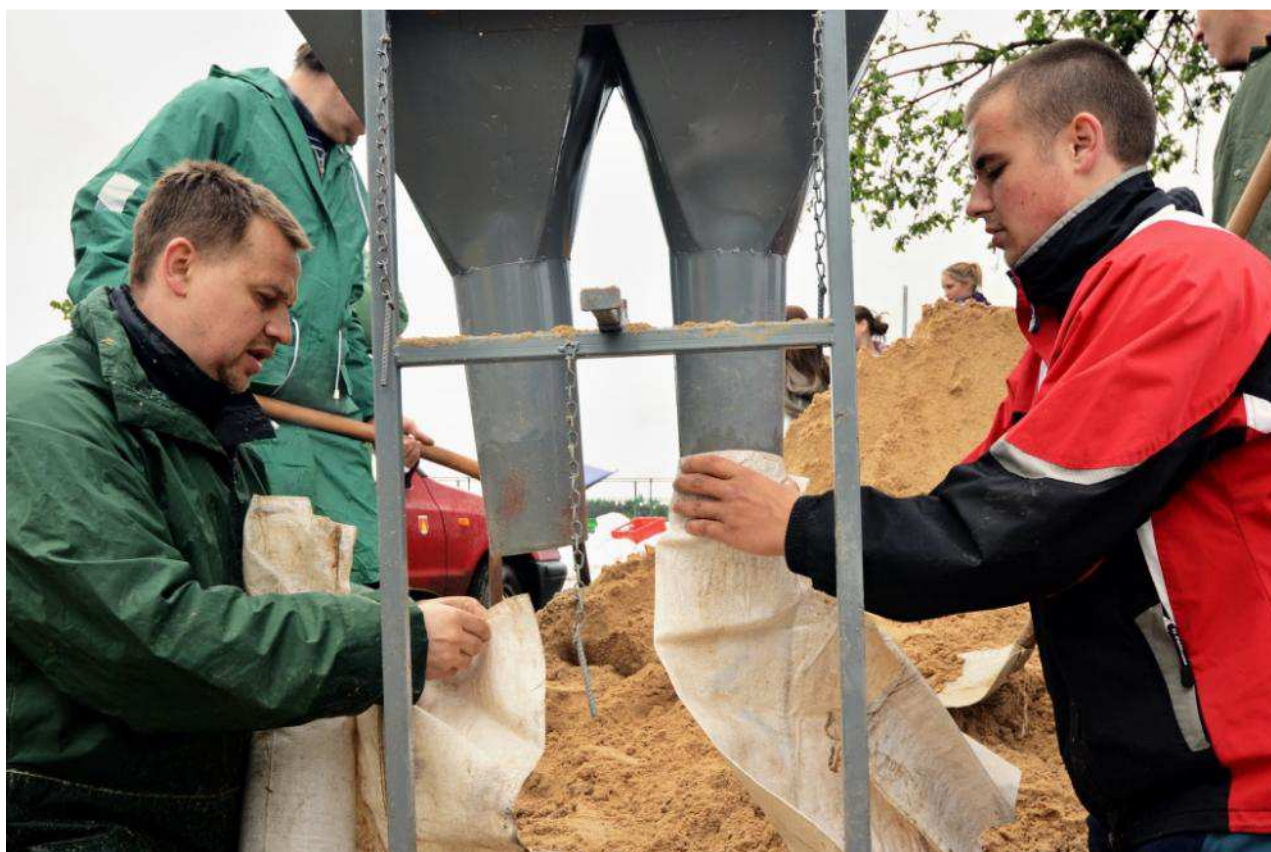
Plnění pytlů pískem
