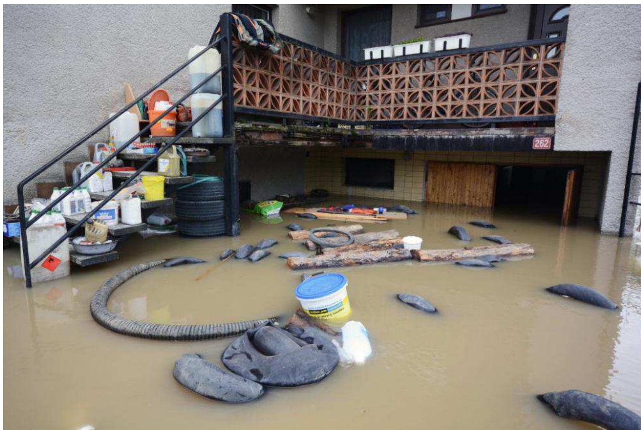
Zatopené garáže v bytovkách
