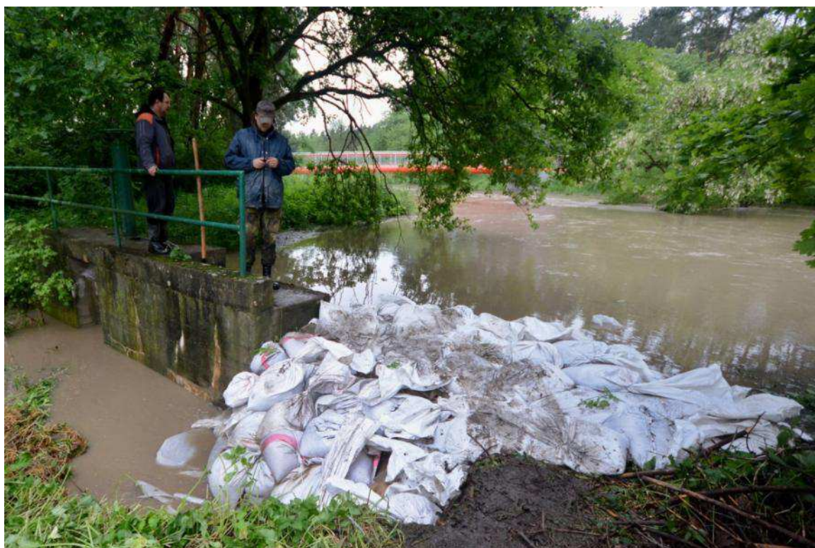
Protržená ochranná hráz na odtokovém potoce rybníka Peklo ucpaná pytli s pískem
